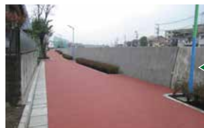
⑥ 仕上げ舗装面の養生 (15 時間以上)・完成
