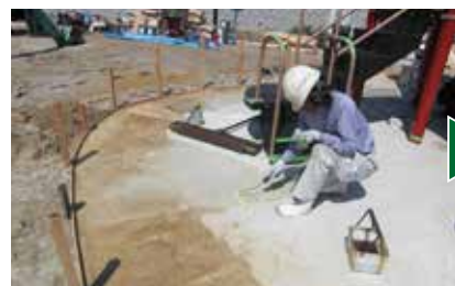
① 清掃・不陸修正・下地処理・プライマー塗布
